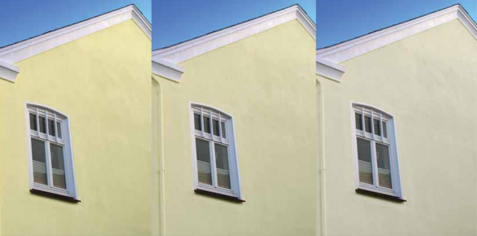
Obr. č.1 Znárodnění změny barevnosti fasády bez omítky Profi Anti-Agingputz po 2, 6 a 12 letech
